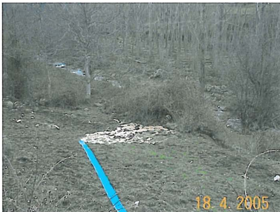
Evacuación del agua al río
