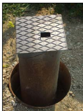
Imagen 3. Cierre provisional del sondeo.
