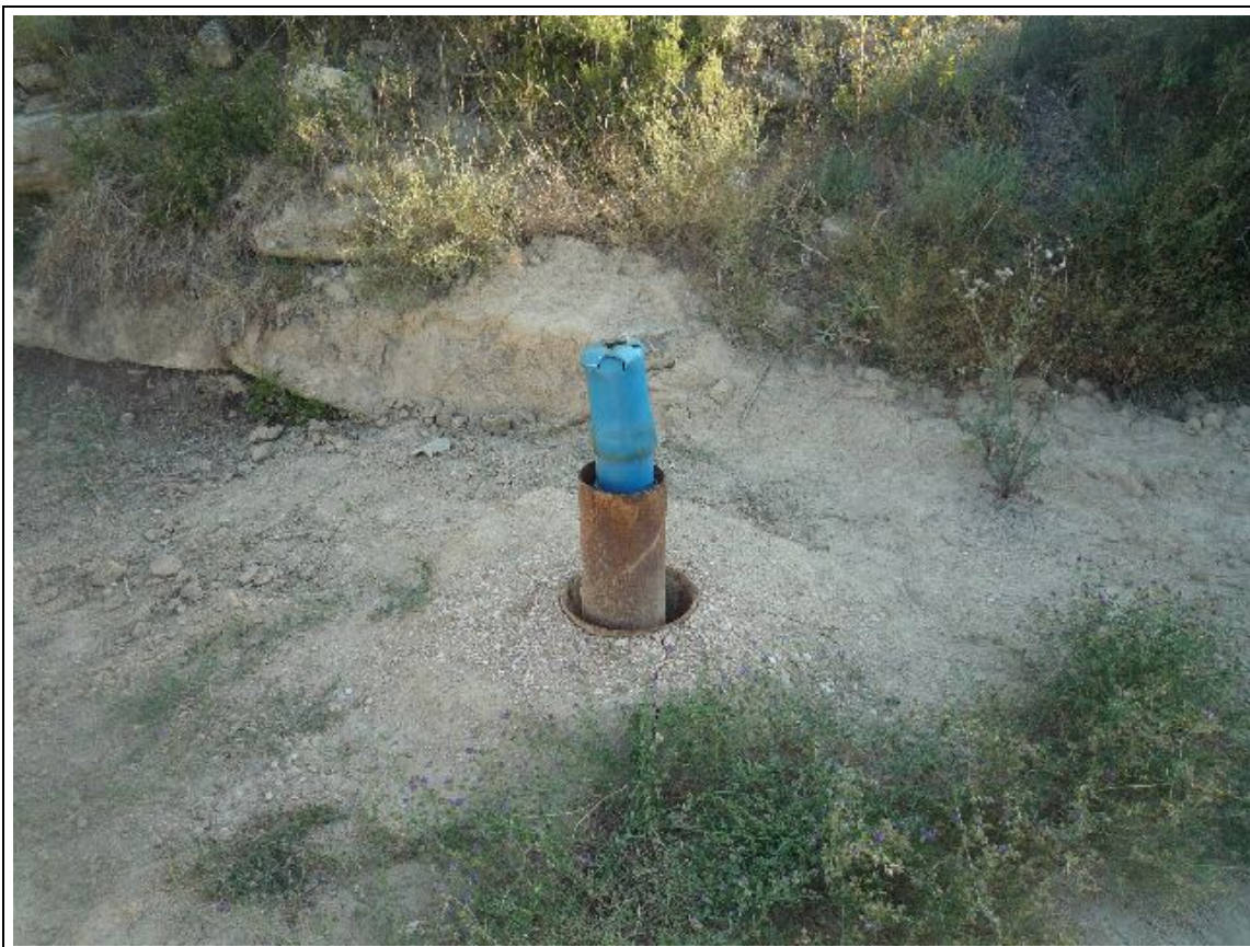
Vista general estado actual (01/09/2010)
