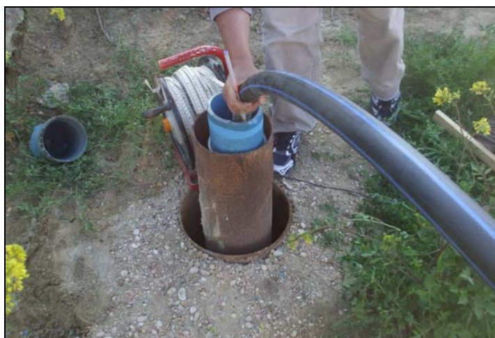
Imagen 2. Inyección de agua en el sondeo.
