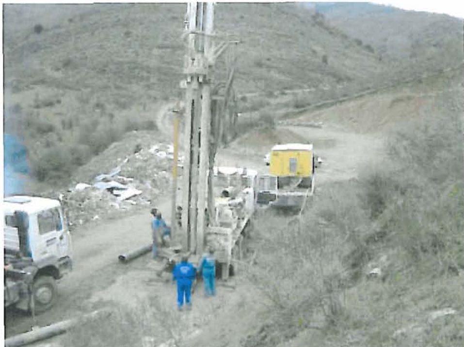
Perforación del emboquille (6/12/04 11:00)
