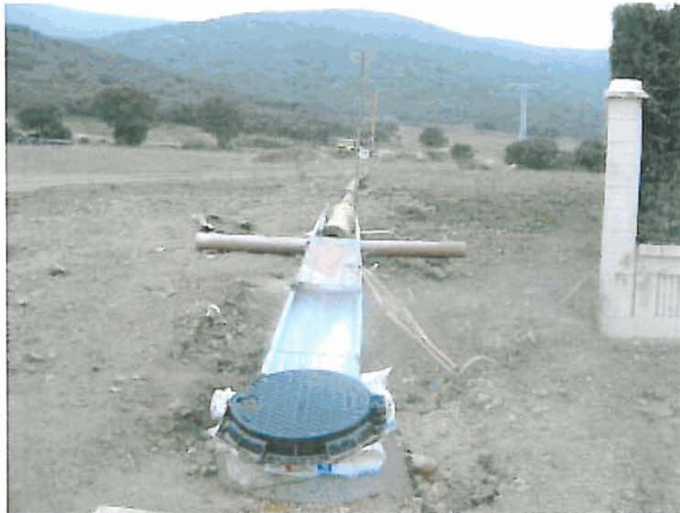
Pitot del aforo del pozo del Ayuntamiento
