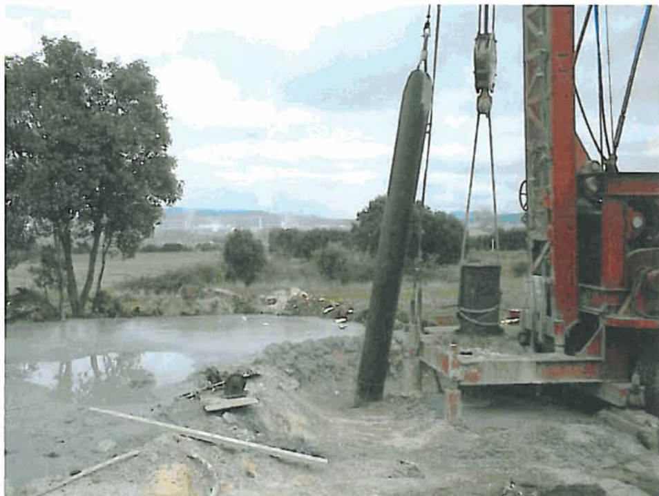
POZO DE ABASTECIMIENTO EN PERFORACIÓN ACTUALMENTE
