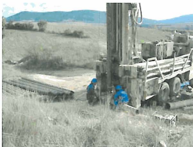
Entubación del sondeo
