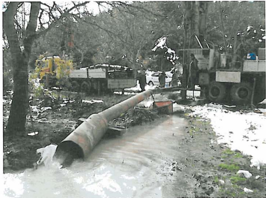
Perforación y prolongación de la pipa para evacuación del ripio.
