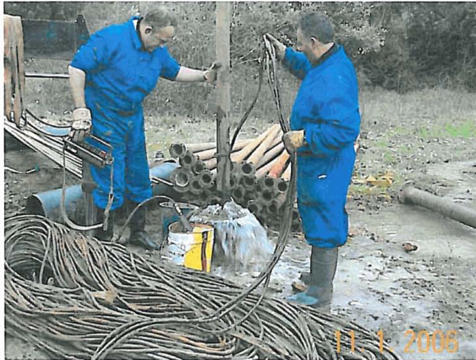
Montaje del equipo de aforo
