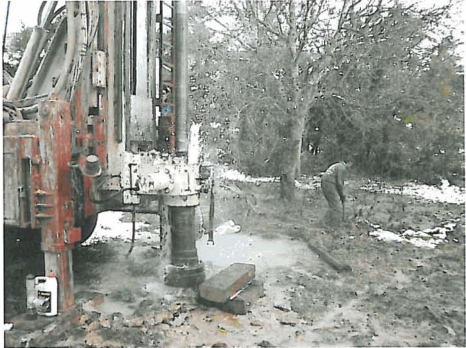
Perforación y prolongación de la pipa para evacuación del ripio.
