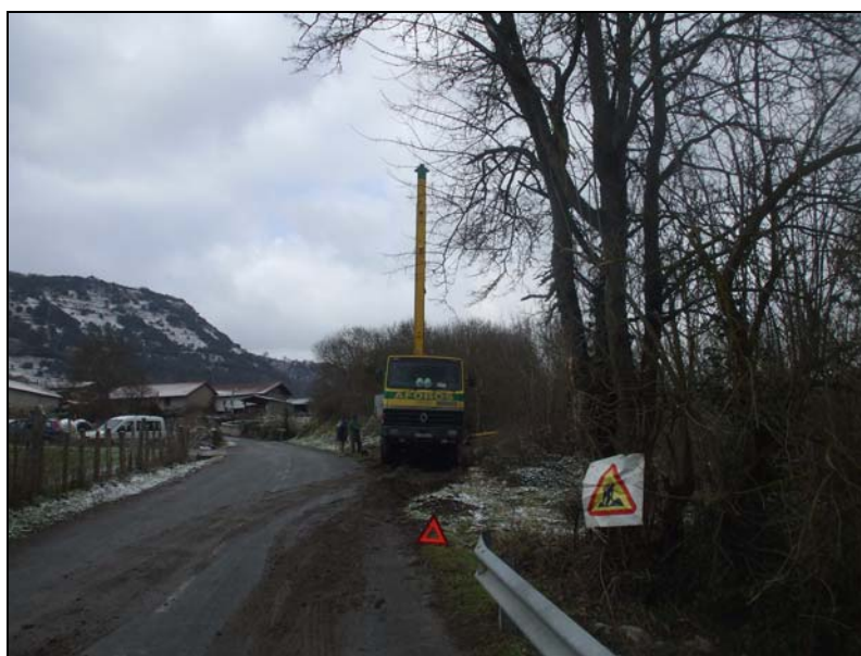
Imagen 3. Otra vista general del equipo de bombeo.
