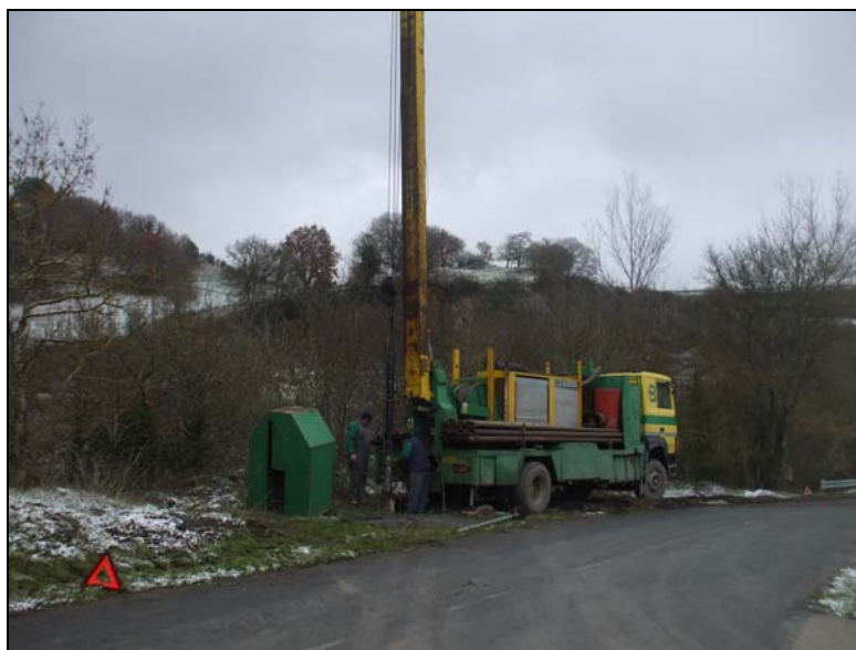
Imagen 2. Vista general del equipo de bombeo, durante la instalación del equipo.
