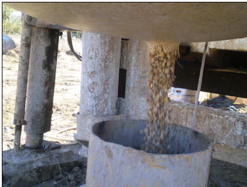
Imagen 7. Colocación del empaque de gravas.
