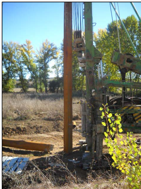
Fig.3. Detalle de las labores de perforación
