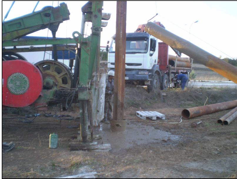
Imagen 2. Primeros metros de perforación.
