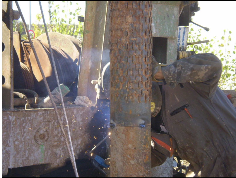
Imagen 6. Trabajos de soldadura durante la entubación.
