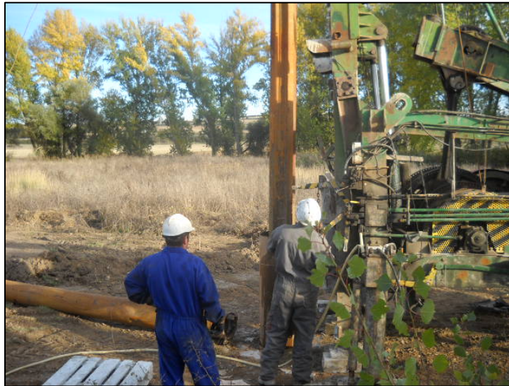
Fig.6. Aspecto de las labores de Entubación
