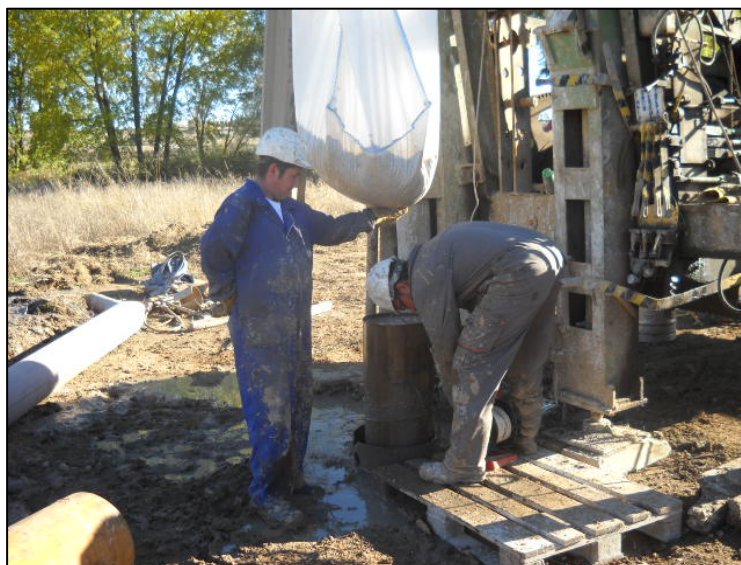
Fig.3. Detalle de las labores de engravillado.
