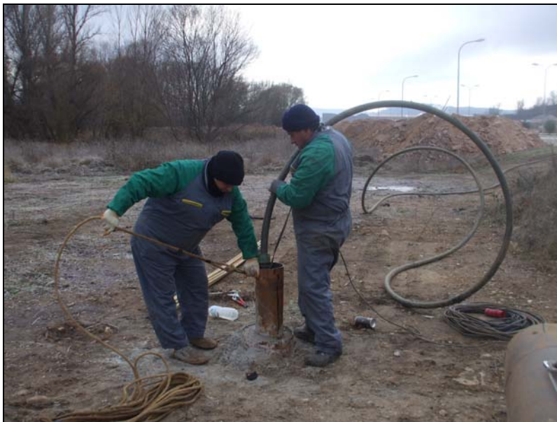
Imagen 2. Instalación del equipo de bombeo.
