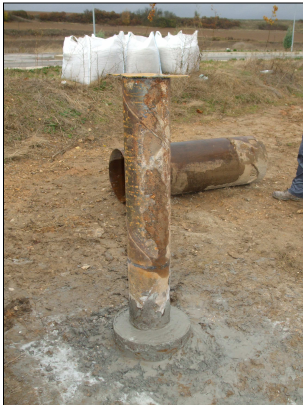
Imagen 10. Cementación el piezómetro.
