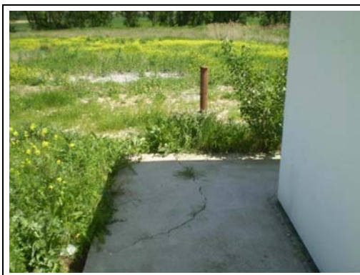
200970024 Vista de piezómetro (15/07/2011)
