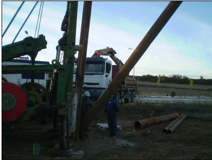
Imagen 4. Final de la perforación.
