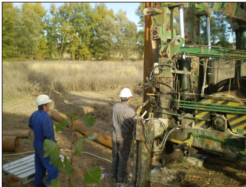
Imagen 3. Perforación de los cuatro primeros metros.
