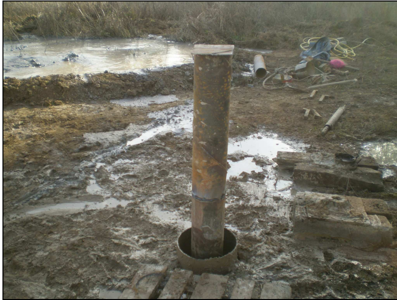
Imagen 9. Aspecto final del cierre provisional del sondeo, antes de cementar.
