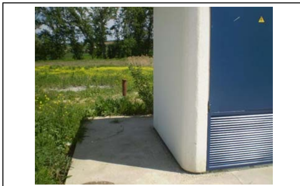
200970024 Piezómetro desde caseta electricidad (15/07/2011)
