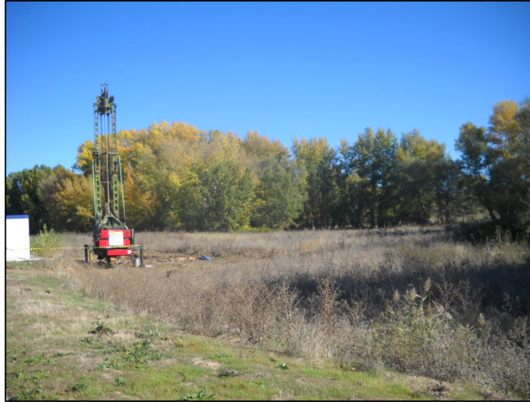
Fig.3. Vista del lugar de emplazamiento de la Maquina.
