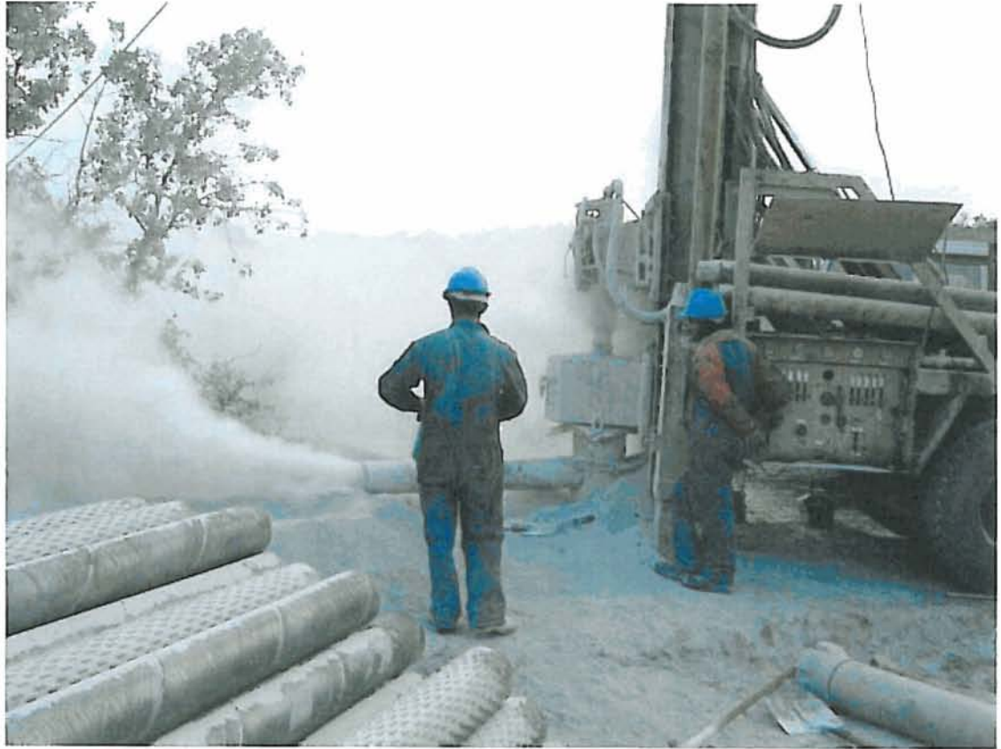
Perforación sondeo (Profundidad 180 m)
