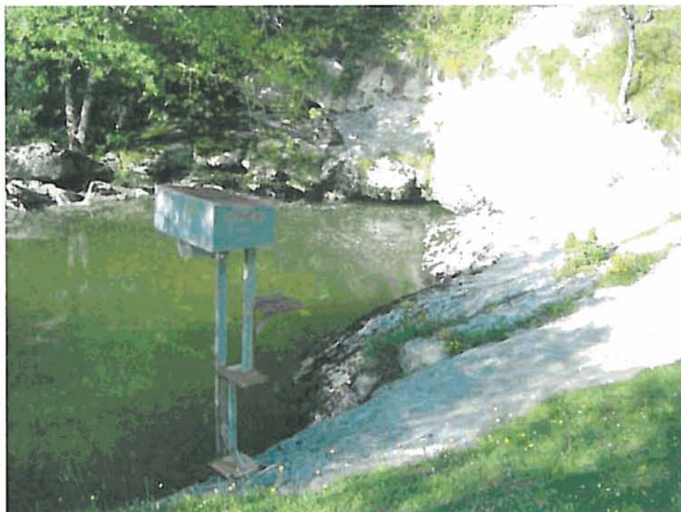
Cueva del agua del Jerea durante el bombeo. (23/5/05)
