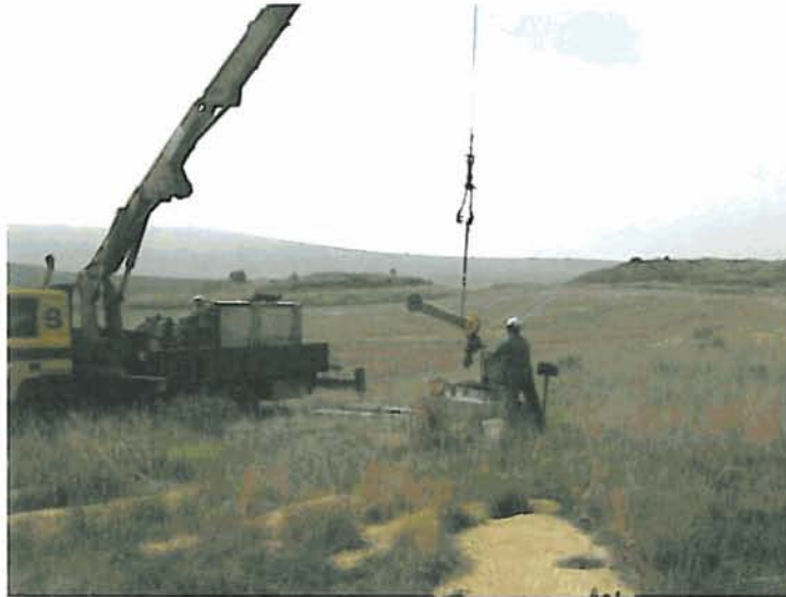
Descendiendo el tubo aforador
