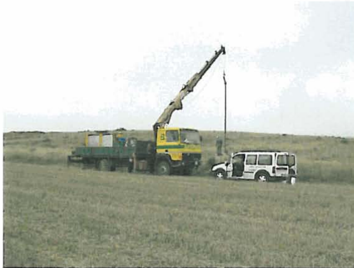
Vista del emplazamiento durante la introducción de la tubería
