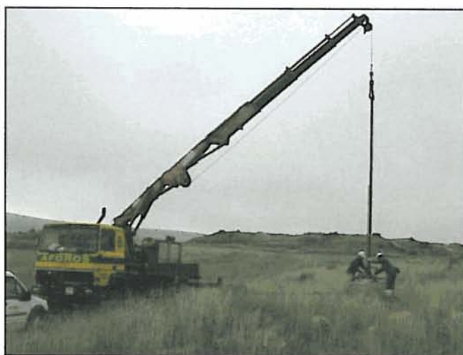
Figura 1. Situación de la máquina de aforos.
