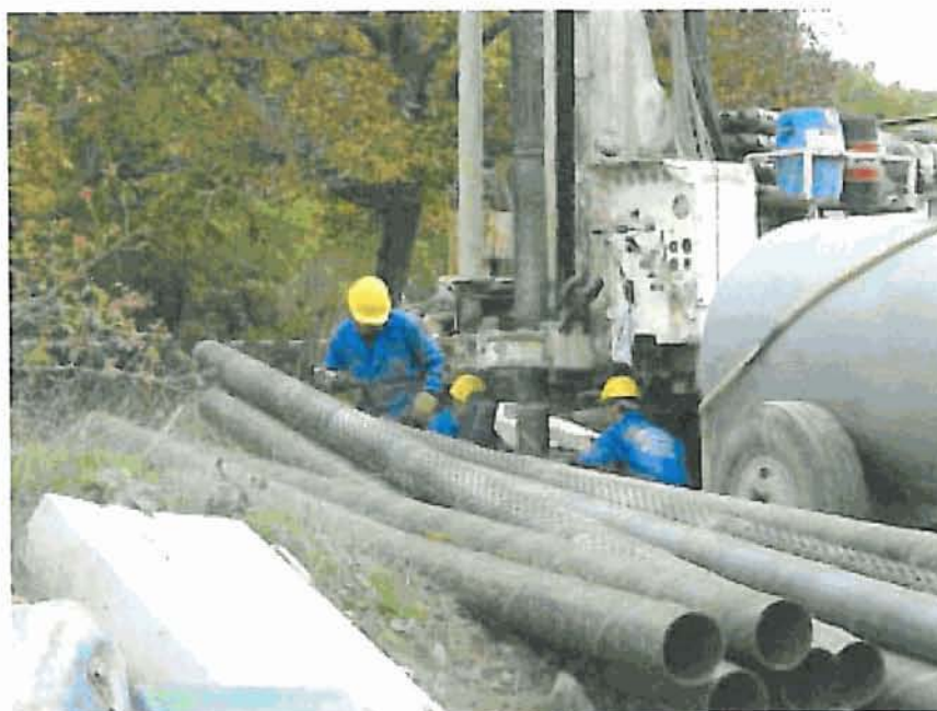
Entubación del sondeo
