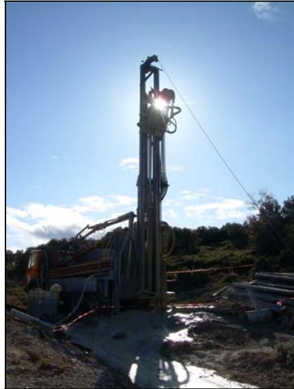
Se perfora durante toda la jornada con inyección de agua y espumante con el objetivo de recuperar todo el material posible. La velocidad de avance de la perforación es de unos 12 m/h.
