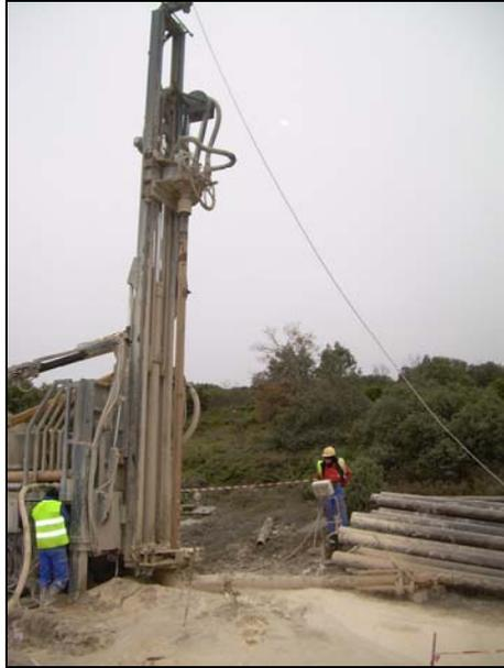
Al alcanzar los 183 metros de profundidad, se produce una pérdida de barrido durante unos 8 m producidos por la avería de la bomba. Tras reparar la avería se continúa con la perforación, y al alcanzar los 198 m de profundidad se observa un importante aporte de agua.
