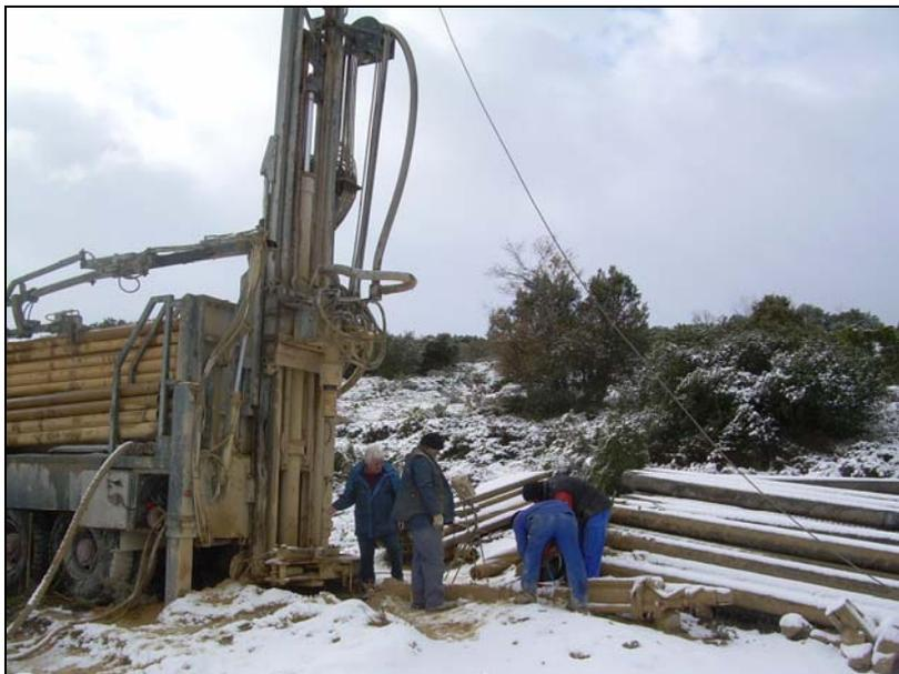
Tras consultar de nuevo con la CHE, quien lleva a cabo el diseño de la columna de entubación, comienzan las labores de entubación del sondeo a las 12:45 h. La columna a instalar es la siguiente:
