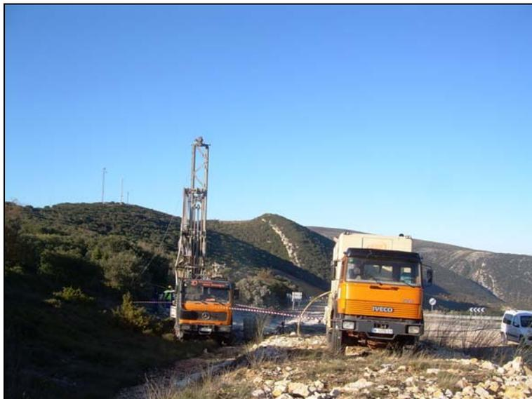
Sobre las 11:30 horas comienzan las labores de perforación del emboquille con un diámetro de 324 mm hasta una profundidad de 6 m. Una vez finalizada la perforación se lleva a cabo la entubación del emboquille con tubería ciega en chapa de acero helicoidal de 300 x 5 mm.
