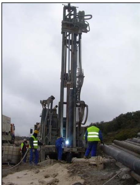
Tras la entubación de los primeros metros, se continúa con la perforación del sondeo con un diámetro de 220 mm, introduciendo agua y espumante durante la perforación, ante la prácticamente nula expulsión de material que se produce en esta zona.
