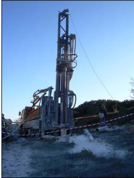
Al alcanzar los 47 metros de profundidad, tras comprobar el peligro de atrapamiento de la maniobra por la ausencia de retorno de agua, espumante y rípios de perforación, se decide entre CGS y Consulnima, llevar a cabo la entubación de los primeros 30 metros con el objetivo de intentar recuperar el barrido.
