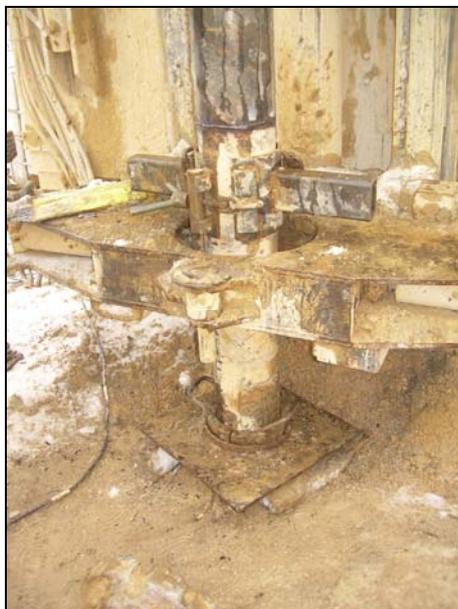
A las 11:30 h finalizan la entubación con la colocación de 285 m de tubería metálica de 180 mm de diámetro y 4 mm de espesor.
