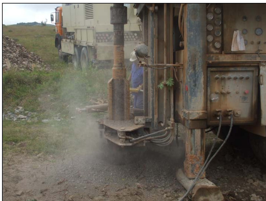
Imagen 2. Perforación del emboquille.
