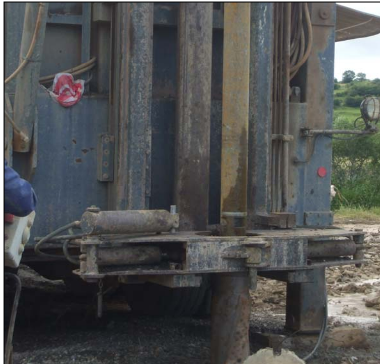
Imagen 9. Colocación del martillo de 280 mm antes de reperforar.
