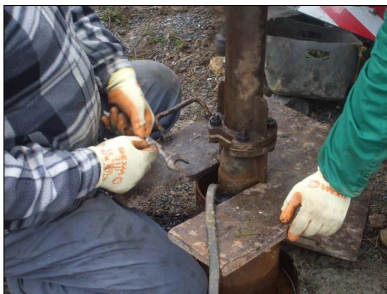
Imagen 2. Instalación del equipo de bombeo.
