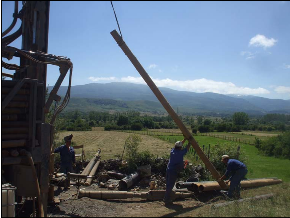
Imagen 10. Labores de entubación del sondeo.
