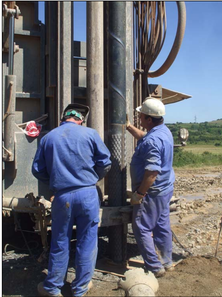
Imagen 7. Labores de entubación del sondeo.
