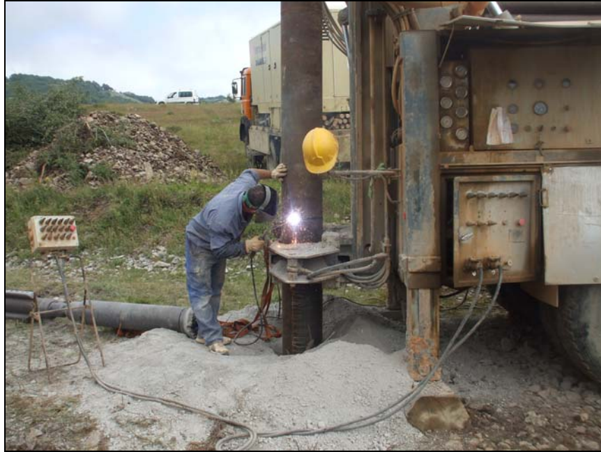
Imagen 3. Soldadura de la tubería de emboquille.
