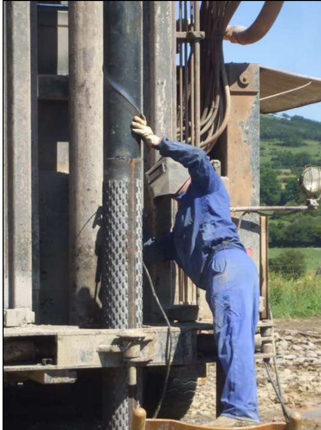
Imagen 11. Soldadura durante la entubación del sondeo.
