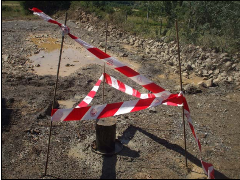
Imagen 14. Aspecto del cierre provisional del sondeo de Fontibre.
