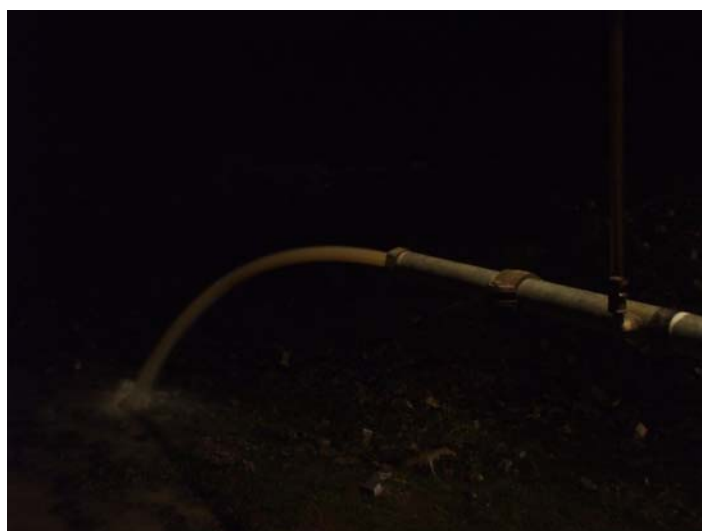
Imagen 6. Caudal extraído durante el cuarto escalón.
