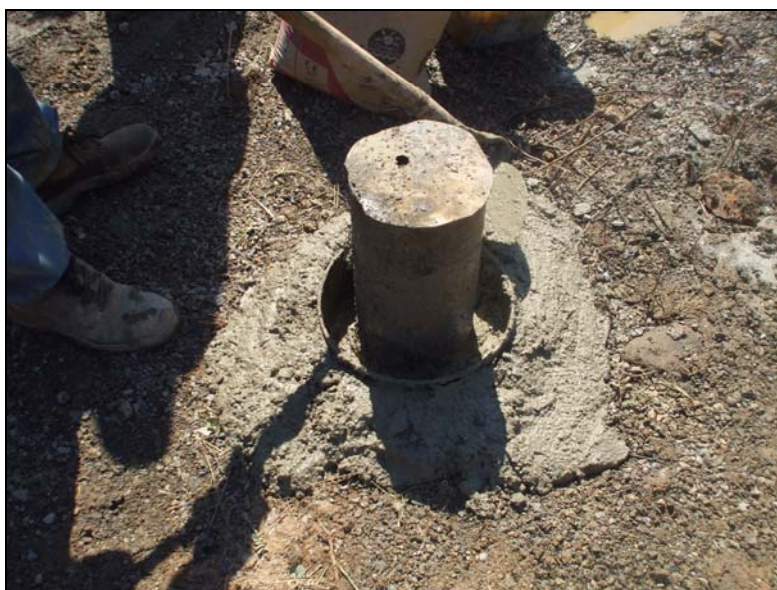
Imagen 13. Cementación del emboquille del sondeo.
