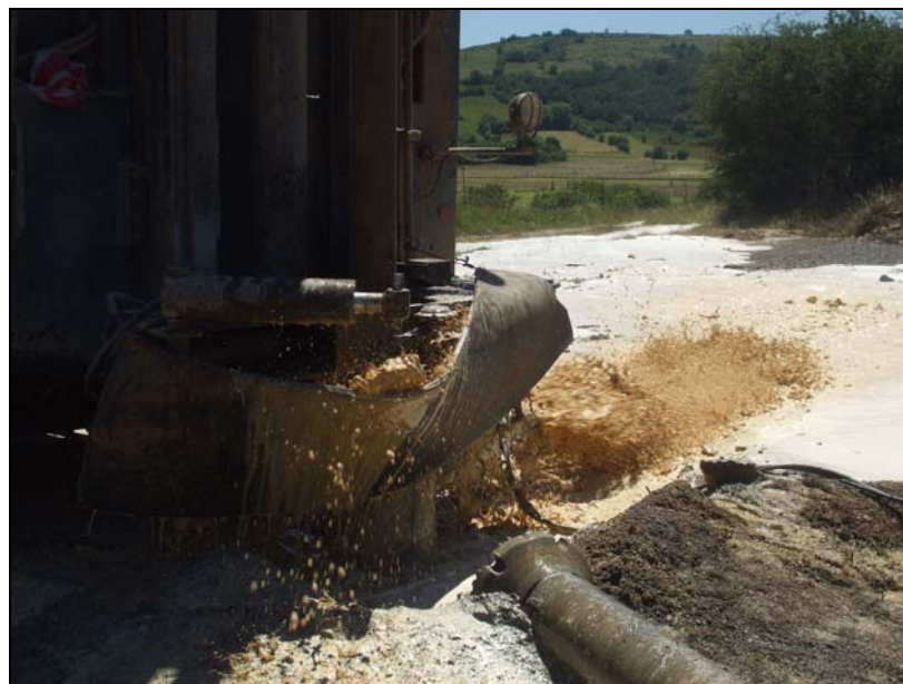
Imagen 4. Perforación con el martillo de 220 mm.
