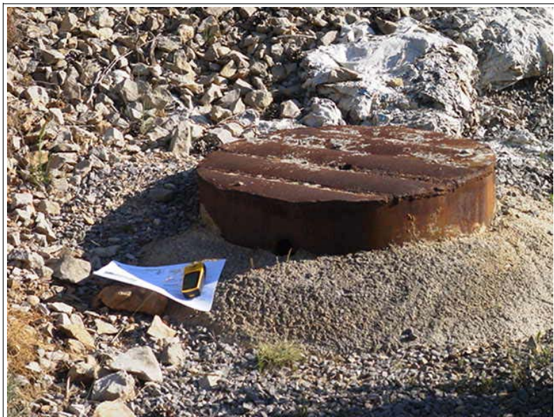
DETALLE DEL BROCAL. FOTO U. JAIME I, CASTELLÓN (13/06/2001)
