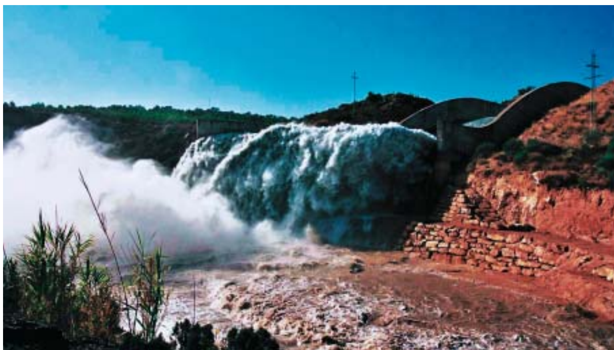
Aliviadero de la Presa del Embalse de Caspe
