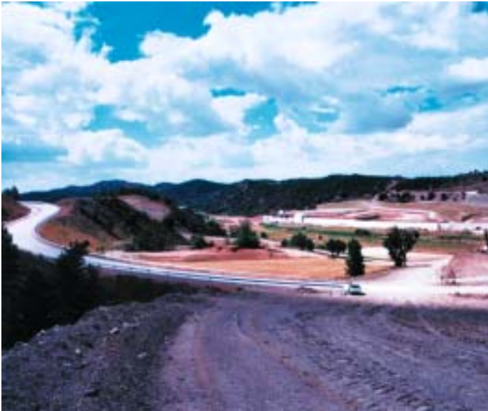
Desvío de carretera y obras del Embalse de Lechago (Teruel).
