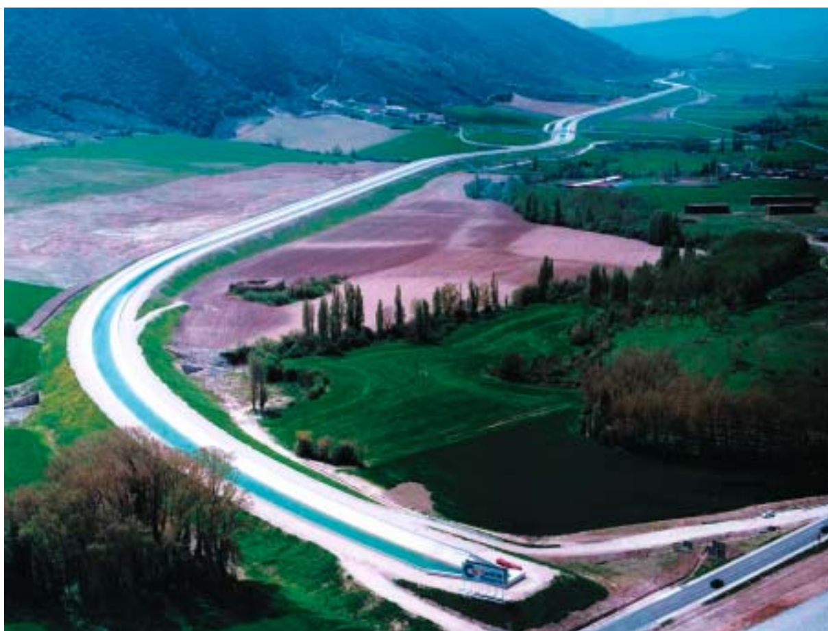
Canal de Navarra Tramo 3-Sifón.
