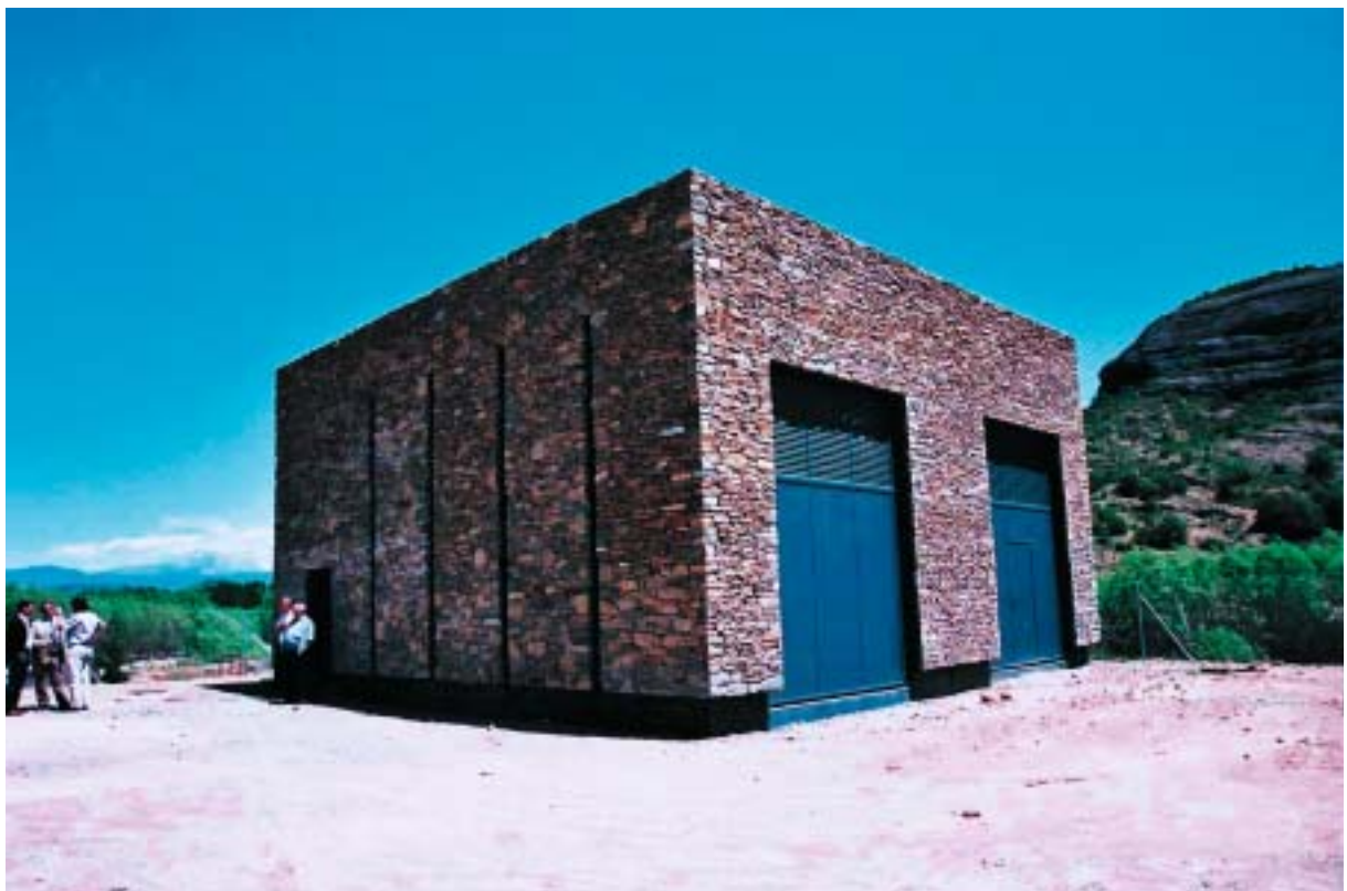
Estación de bombeo de aguas residuales. Graus (Huesca).
