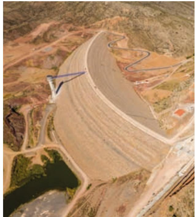
El Proyecto vigente contempla la construcción de una presa de materiales sueltos, tipo heterogéneo con núcleo central impermeable, y espaldones de escollera caliza en ambos paramentos, con 82,58 m de altura sobre cimientos y 793,84 m de longitud de coronación, situada en el río Grío. La capacidad del embalse es de 103,3 hm<sup>3</sup>.
