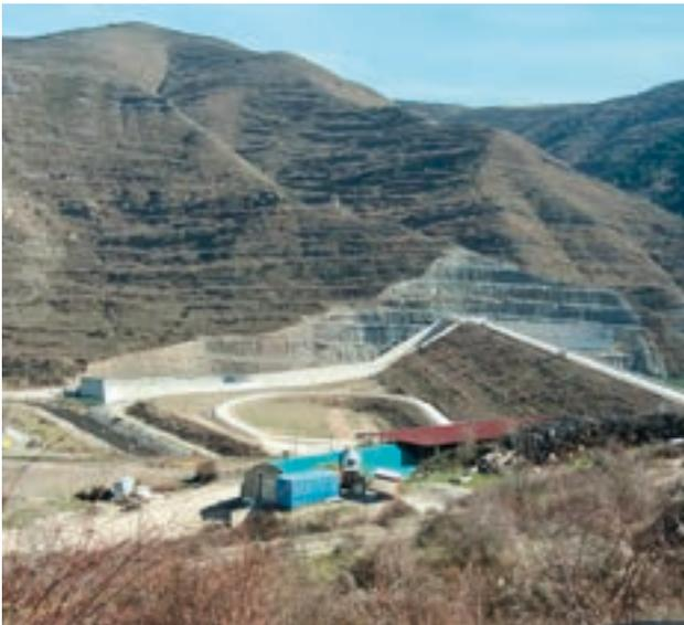
El proyecto comprende la construcción de una presa de materiales sueltos con pantalla asfáltica como elemento impermeable. Es de planta recta con una longitud de coronación de 356,35 m, y una altura sobre cimientos de 45,6 m. El volumen de materiales asciende a 885.514 m<sup>3</sup>. La capacidad de embalse útil es de 7,1 hm<sup>3</sup> y posee un aliviadero lateral de labio fijo. En las obra se incluye la variante de la carretera LR-250 de 2.700 m, de longitud.
