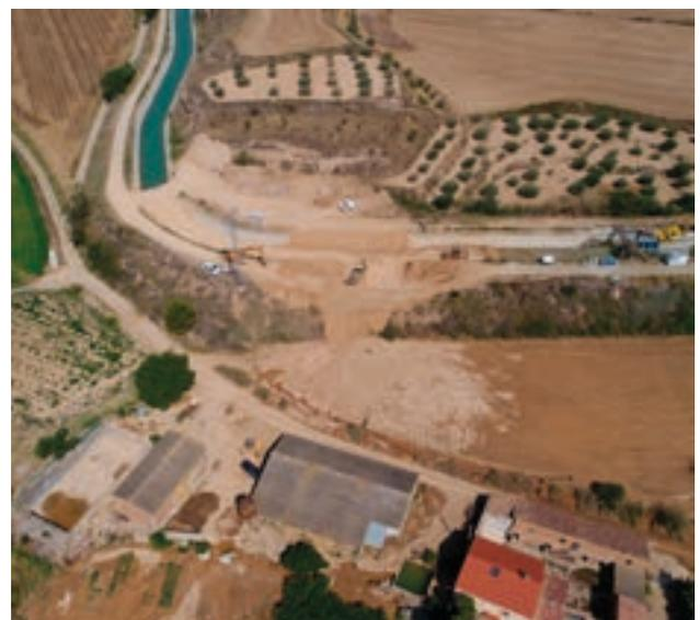
Las actuaciones para reparar toda la zona dañada del canal consistieron en la excavación y el saneamiento de las soleras y taludes de todo el tramo afectado, así como en las zonas que presentaban indicios de disoluciones y sifonamiento. Posteriormente se procedió al relleno con escolleras, hormigón fluido y zahorras, para reponer sobre los mismos la solera y los cajeros de hormigón del canal.
