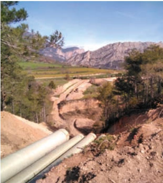
Las obras de la segunda fase de los nuevos regadíos en Peramola consisten en la ejecución de las tres conducciones para la distribución de los riegos que forman parte de la red primaria. Se trata de tres tuberías en paralelo de diámetro 500 mm de poliéster reforzado con fibra de vidrio y en una longitud de 980 m cada una. En los tramos de pendiente superior al 10% se coloca tubería de acero soldado helicoidal. Estas tuberías se conectarán con la red secundaria de los regadíos de Peramola.
