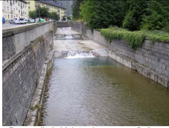
Tramo canalizado del río Aragón a su paso por Canfranc-Estación
