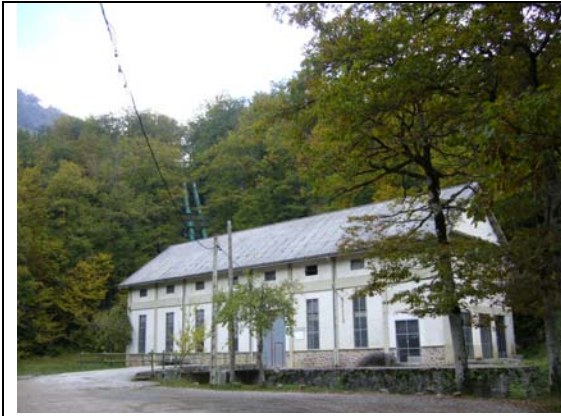
Central hidroeléctrica de Betolegui. Recibe agua canalizada del embalse de Irabia y del Canal de Lagartza
