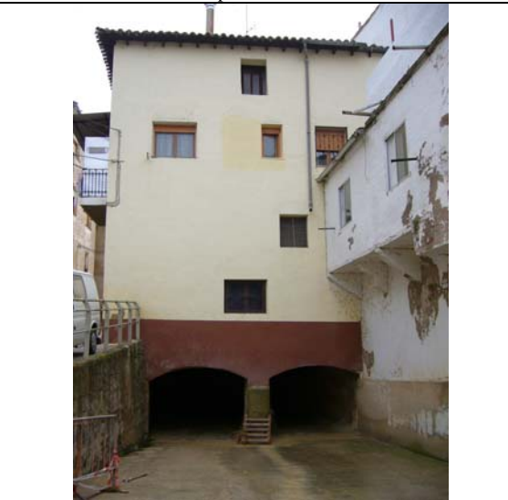
Comienzo de la canalización del barranco de la Cabrería en la localidad de Caparroso
