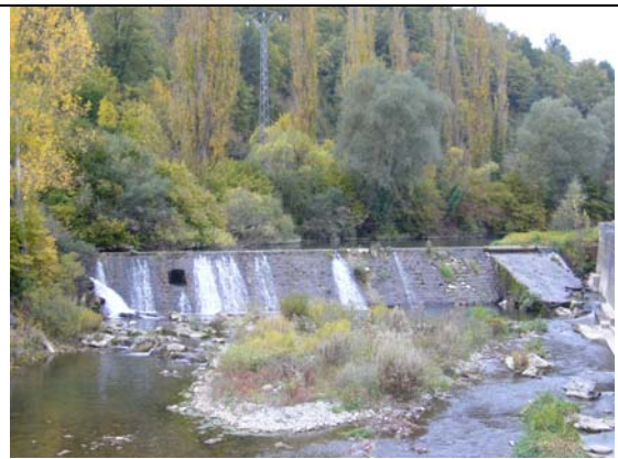
Azud de antiguo molino aguas abajo de Escaroz. Aún mantiene la rampa que se utilizaba para el paso de las almadías
