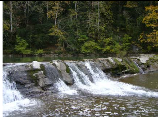
Azud para represar un poco el agua en las inmediaciones de un área recreativa cerca de la central hidroeléctrica de Betolegui
