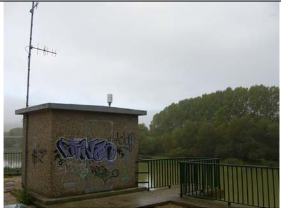
Estación de aforo nº 5, Aragón en Caparroso. La sección se mide aguas arriba ayudándose de un cable. El agua llegó a la base de la pared de la estación en las riadas de abril de 2007
