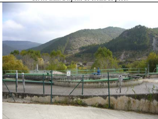
Estación depuradora de Aoiz. Debido al crecimiento urbanístico, ha quedado muy embebida en el pueblo
