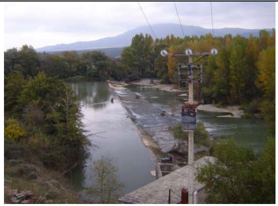
Azud de la central hidroeléctrica de Cáseda. Deriva agua por la margen derecha por un canal que también sirve para abastecer la fábrica de Viscofan y para regadíos
