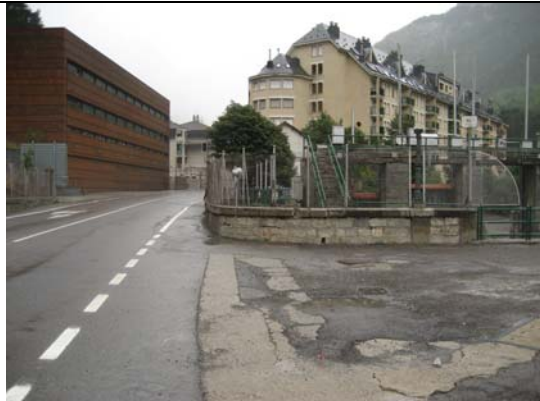
Canfranc-Estación. Zona afectada por las riadas de septiembre de 2006 que provocaron inundaciones en garajes y el corte de la carretera N-330. El agua alcanzó un metro en este punto
