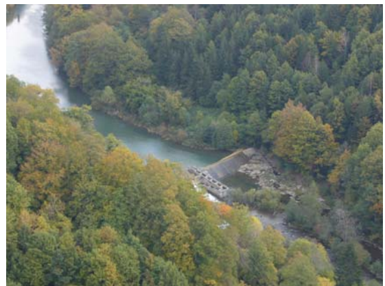
Azud de la central hidroeléctrica de Olaldea I. Deriva agua por margen derecha que discurre canalizada hasta la central. Dispone de escala de peces
