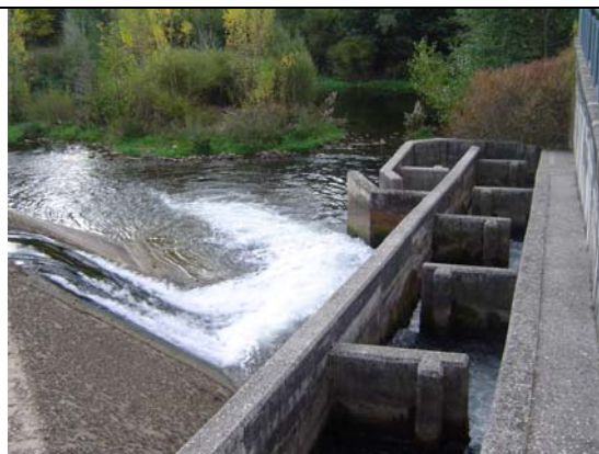
Detalle de la escala de peces del azud de la central de Ecay
