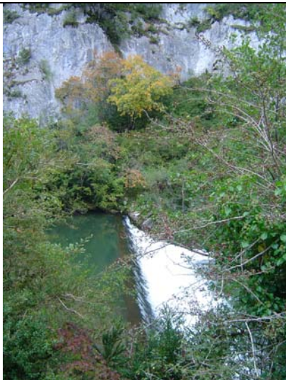
Azud de la central hidroeléctrica de Aribé, explotada por la Cooperativa Aizpea. Deriva agua por margen derecha
