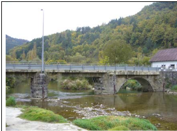
Piscina fluvial de Escaroz. Se hizo rebajar la altura de los postes para dejar mayor luz bajo el puente en caso de crecidas del río
