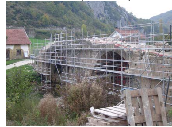
Obras de restauración del puente de Aribé
