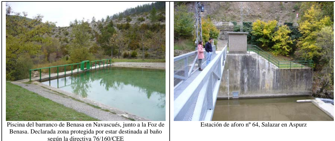
Figura 3.86: Fotografías representativas de algunas de las presiones y características de la masa 540
