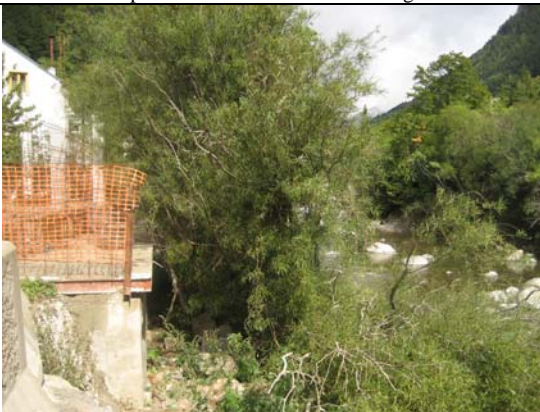
Construcción en zona inundable, Canfranc
