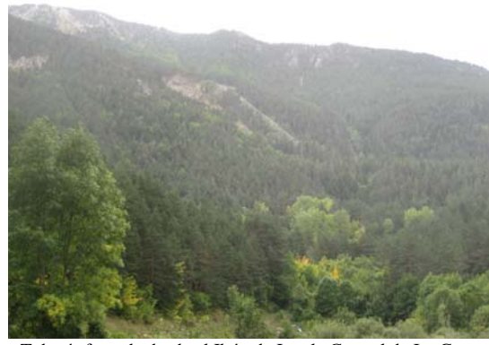
Tubería forzada desde el Ibón de Ip a la Central de Ip. Gran importancia económica e ingenieril. Salva un desnivel de 1000 m.
