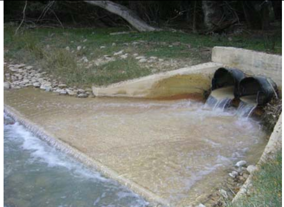
Vertido de la fábrica de Viscofan en el río Aragón. La tubería discurre paralela al barranco de Bancervera. En el cruce de la tubería con el barranco se ha colocado bloques de hormigón que pueden suponer el desbordamiento de dicho barranco en caso de lluvias intensas.
