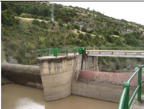
Azud para derivar agua a la central de Villanúa
