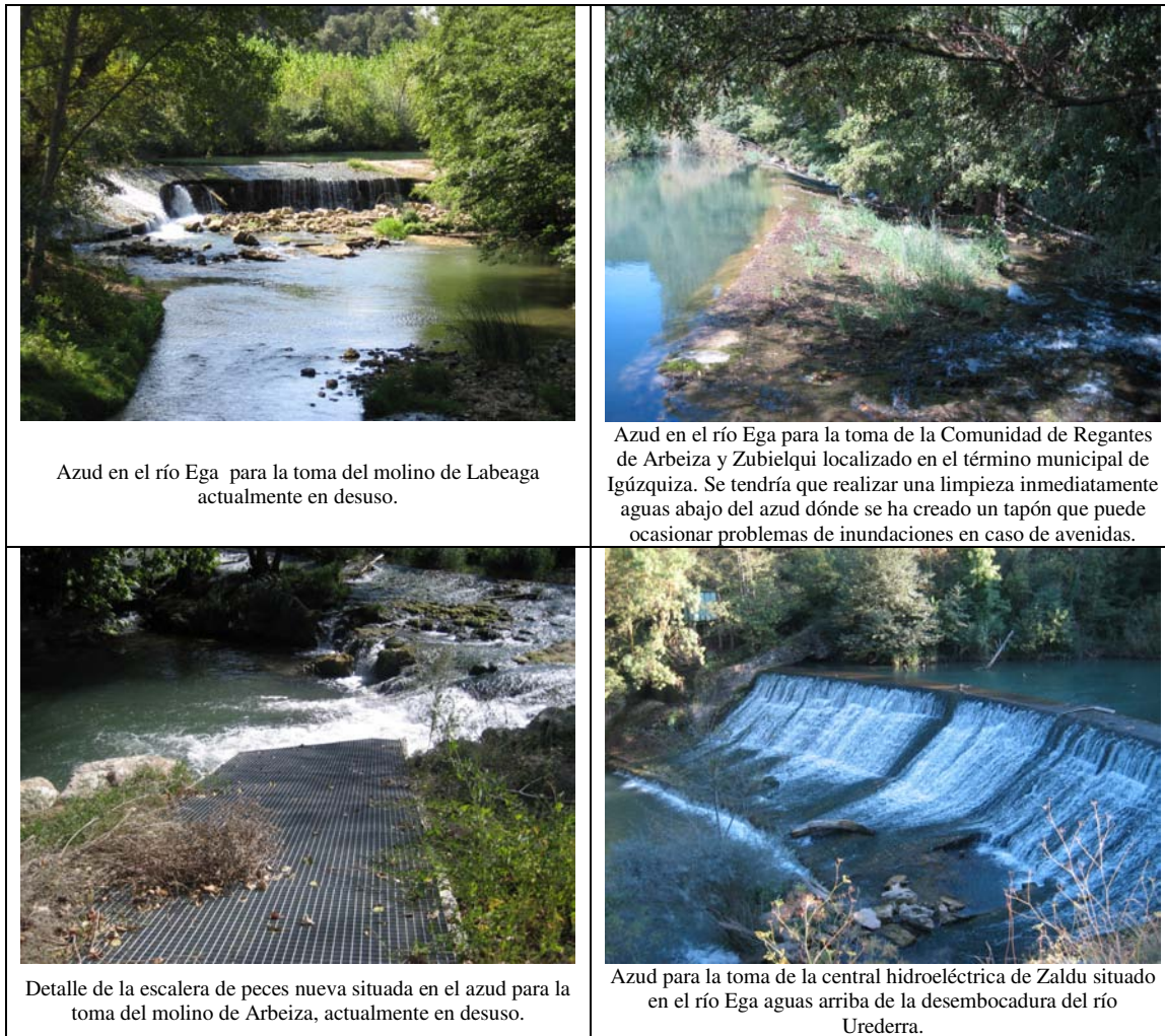
Figura 3.6 (continuación): Fotos representativas de las características y problemas del río Ega desde el río Istora hasta el río Urederra (1742).
