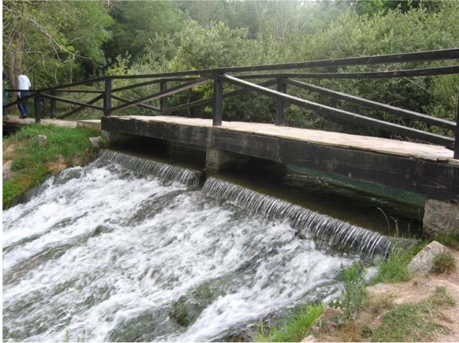
Ref. 17.- Nacimiento del Río Ebro. Detalle del azud que mantiene la lámina de agua estable en el parque.
