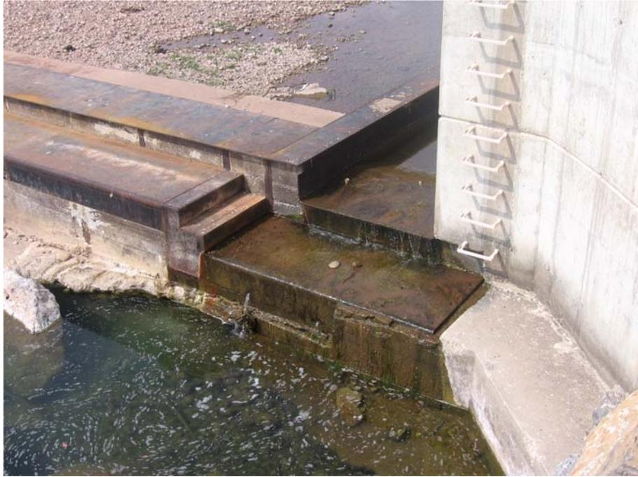
Ref. 15.- Estación de aforos en el río Hijaar en Reinosa - Detalle de la salida del canal de aguas bajas. En la actualidad se va a realizar una rectificación para que los peces puedan superar la estación de aforos.
