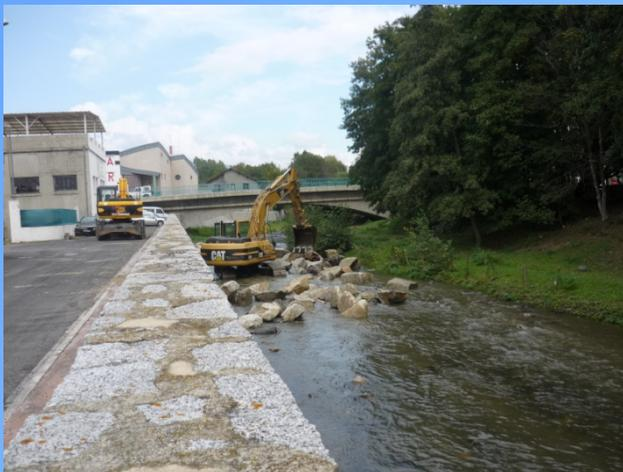
*Création d'une riseberme afin de réduire la largeur du cours d'eau et ainsi augmenter la hauteur de la lame d'eau*
