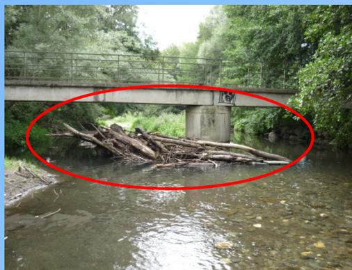
*Pile de passerelle risquant d'être déchaussée puis déstabilisée suite à l'affouillement causé par l'embâcle*
