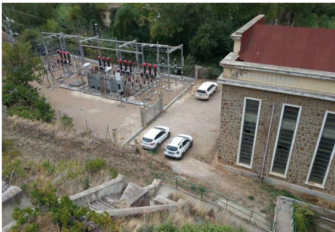
Ilustración 6. Terrenos afectados de la REFCAT 50067A103000260000AK, localizados entre la SET y el edificio de la central que se corresponden con uso improductivo.
