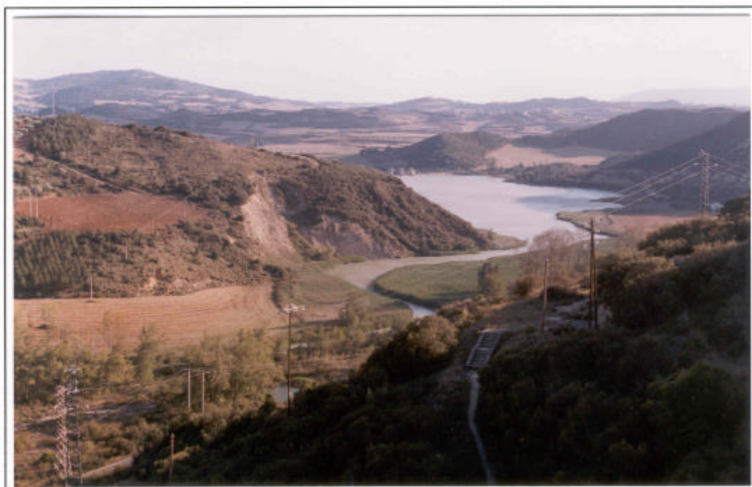
Contraembalse que recoge las aguas de Alloz. Éste presenta una importante cobertura de carrizo, ( Phragmites australis ), debido a que mantiene constante el nivel.
