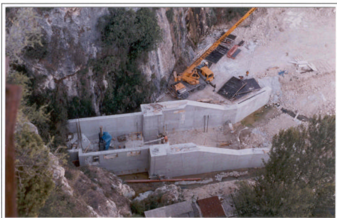
Desagüe de fondo del embalse en reparación.
